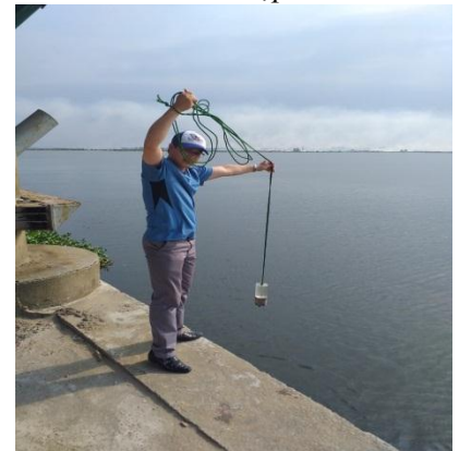
Hình 10. Đập Thảo Long
