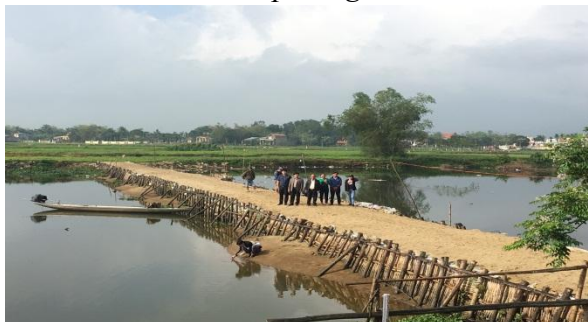
Hình 5. Đập tạm Tứ Câu
