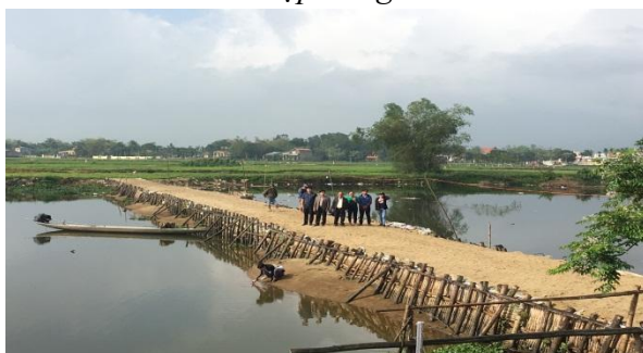
Hình 5. Đập tạm Tứ Câu
