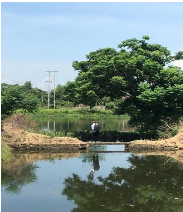
Hình 4: Trạm bơm Từ Cầu
