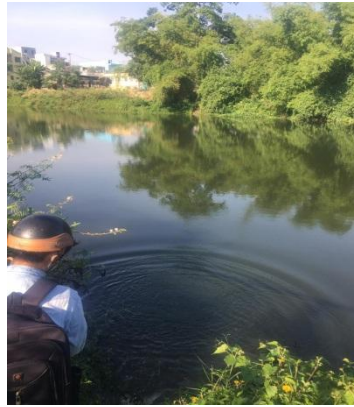
Hình 2: Trạm bơm Túy Loan
